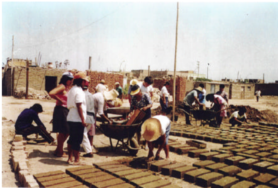
AA.HH.San Carlos De Parque Bajo – Producción de adobes
